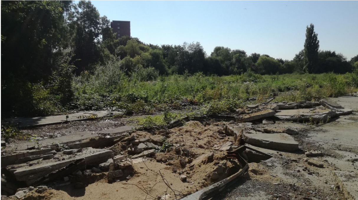
Im Norden Betonplatten mit Offenbodenstellen, im Hintergrund Ruderalfläche im Westen.
